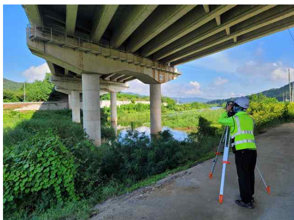
광파기를 이용한 측량 작업
