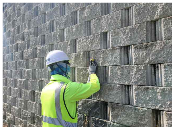
경사계를 이용한 경사도 측정
